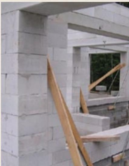
Construction en béton cellulaire
