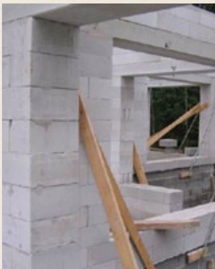
Construction en béton cellulaire
