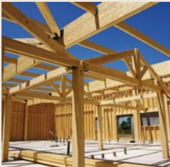
Construction en bois
