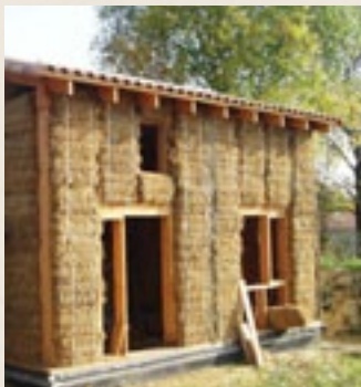
Construction en paille et bois
