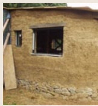
Construction en terre
